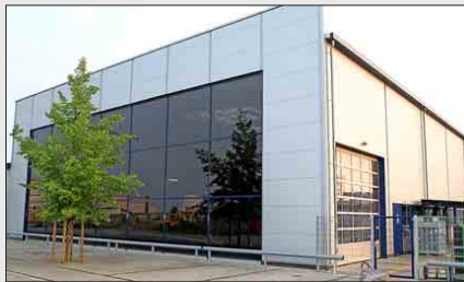
Moderne, energiesparende Bauelemente, große Glasflächen und ein architektonisch gelungenes Design: Die neu entstandene Produktionshalle.
